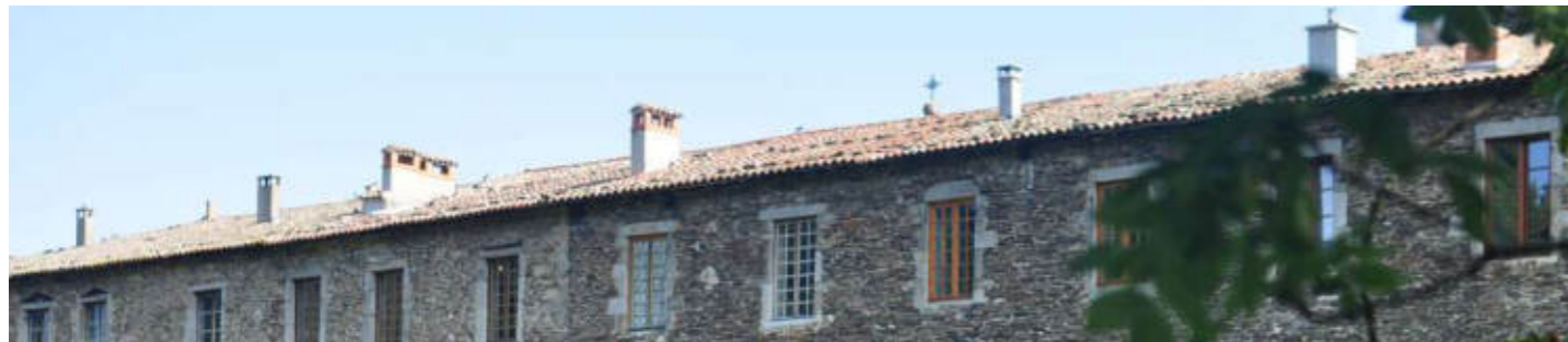
Toitures élévation Sud de la Chartreuse et leur souches de cheminées
