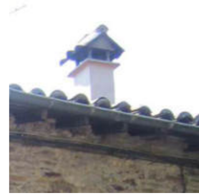
Souche moderne enduite de section relativement faible, mais à chapeau imposant
