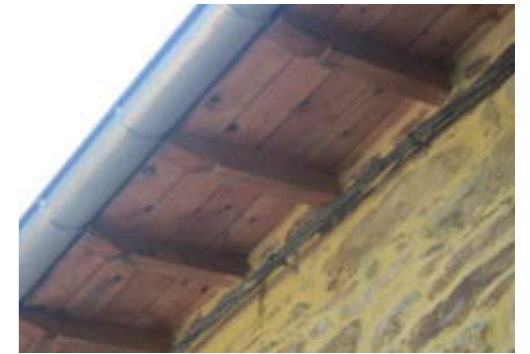
Exemple d’about de chevron chantourné dans la cour des Pères
