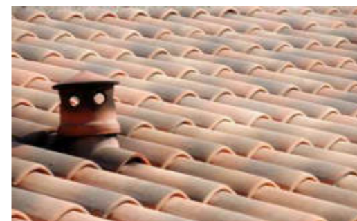
Exemples divers de sorties de toiture avec tuile à douille et lanterne en terre cuite.
