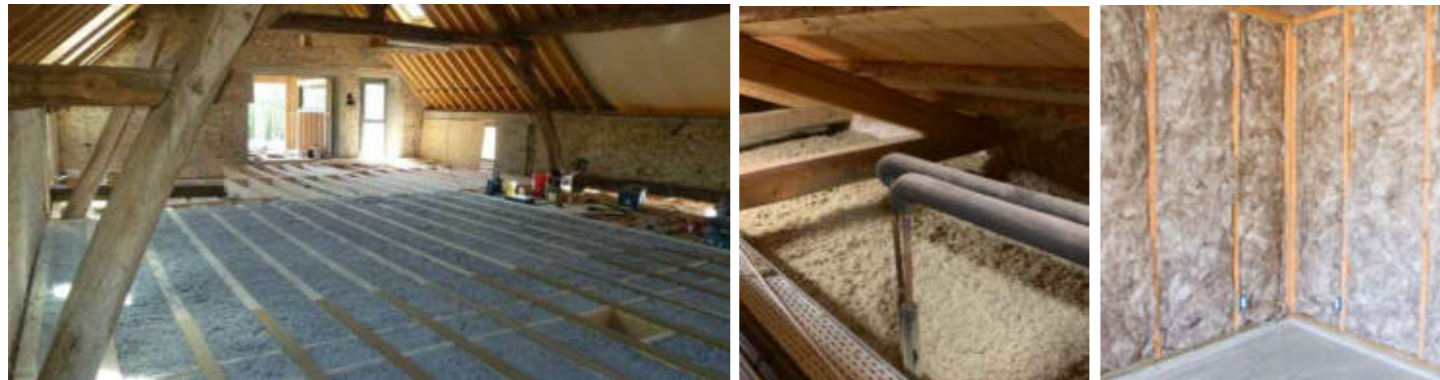
Exemples de planchers de combles isolés avec de la ouate de cellulose
