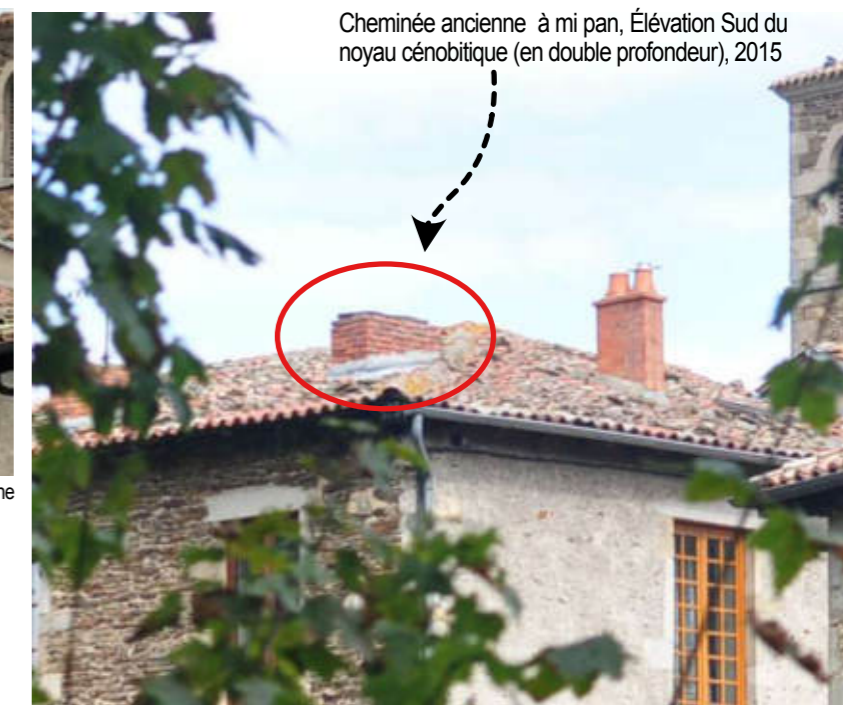
Souches de cheminée, vestige d'une ancienne (à gauche) et souche moderne (à droite) Source : Selarí Feasson Gagnal Goulois, 2015
