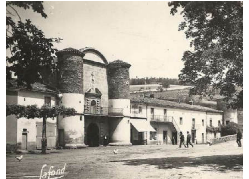
Campagne de travaux -> enduit des élévations fin XIXème s.
