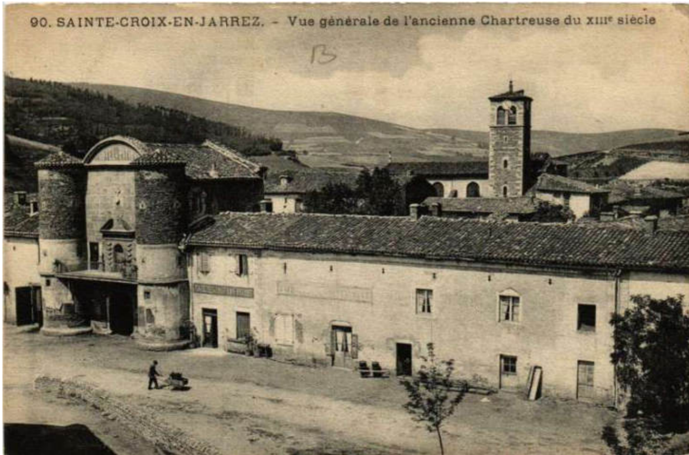
Élévation principale (Ouest) de la Chartreuse au début du X e s. : Les souches sont rectangulaires, en briques, et implantées au niveau du faîtage de toiture. Source : https://cartorum.fr/carte-postale
