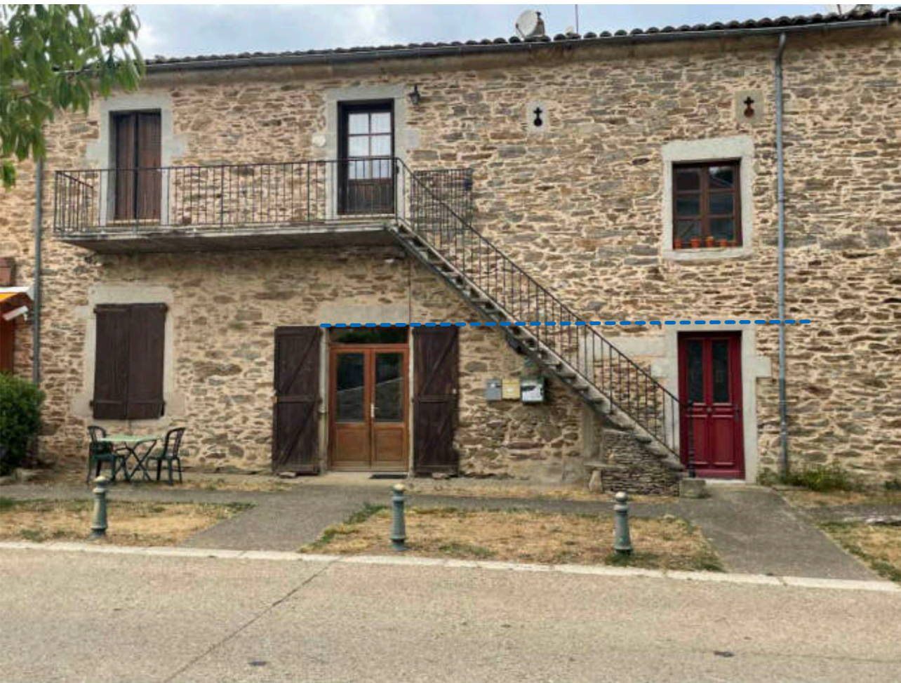
Façade Ouest de la Chartreuse : deux ouvertures de porte en partie Nord Avec une hauteur sous linteau relativement proche pour chacune des portes, l'une a été réalisée avec une imposte fixe assez haute et l'autre sans imposte. L'imposte de gauche est sans doute de hauteur un peu trop importante et aurait pu être légèrement réduite. La porte de droite aurait pu être conçue avec imposte fixe (c'était le cas pour la porte antérieurement en place sur cette ouverture).
