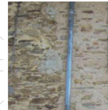
Enduit chaux à pierres vues moderne
