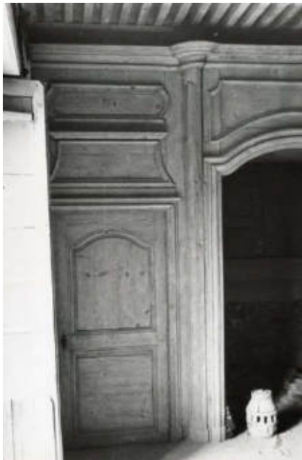
Lambris et revêtements muraux anciens comme ici dans la cellule du Prieur
