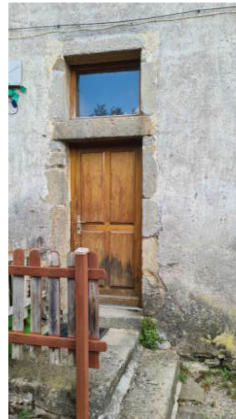
Imposte dans gros oeuvre => privilégier une menuiserie bois à carreaux de format quasiment carré (vertical de préférence) => ici 2 à 3 rangs possibles sur la hauteur. Vitrage clair étiré recommandé.
