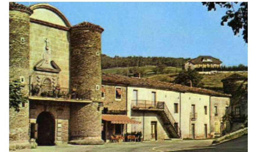
Campagne de travaux 1978-> dépose des enduits d'élévations XIXème s. ; travaux en cours
