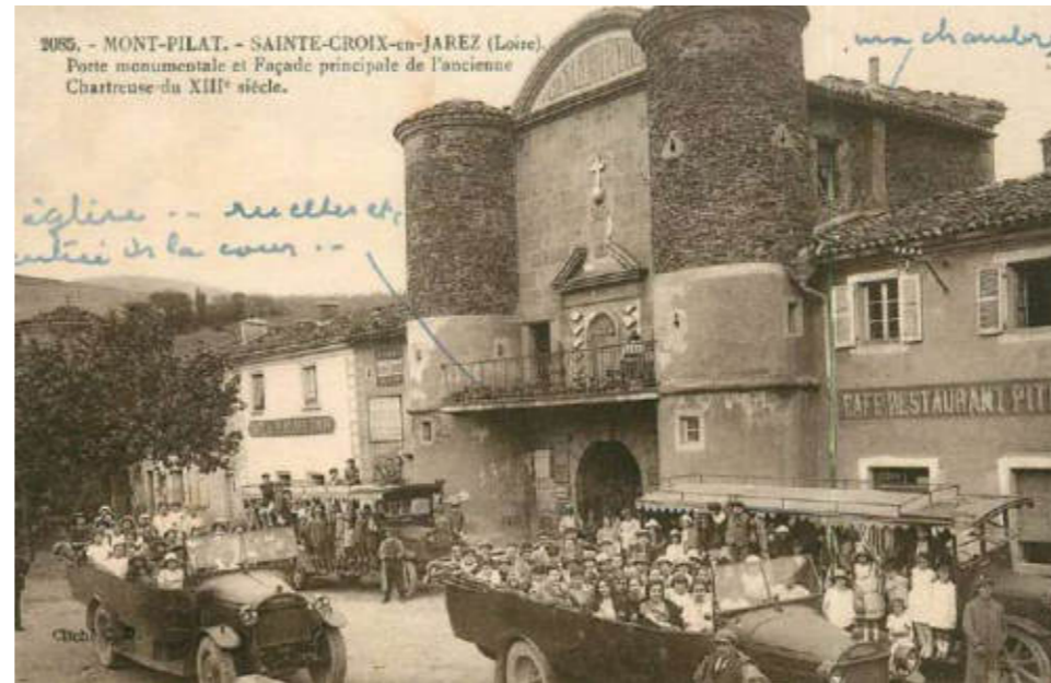
Campagne de travaux achevée-> enduit des élévations fin XIXème s.
