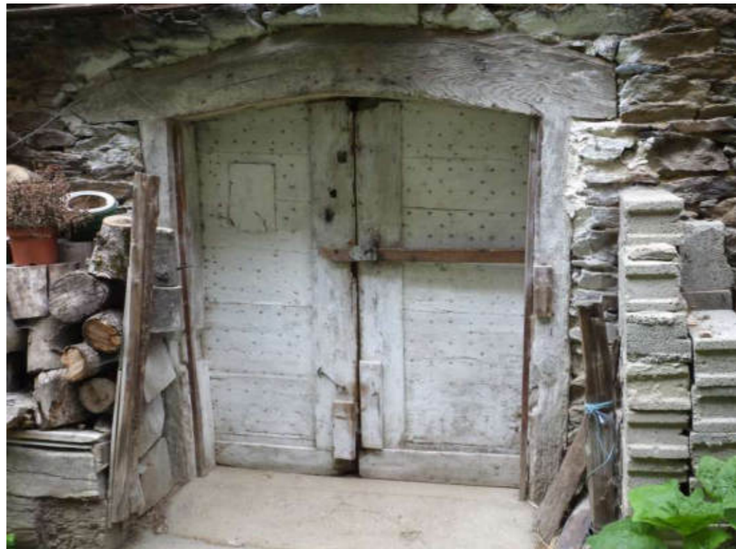
MENUISERIES DE PORTES _ EXEMPLE DE PORTES ANCIENNES DANS LE COUR NORD DE LA COUR DES OBÉDIENCES _ Caractères agricole et fonctionnel de ces typologies de portes, généralement à lames croisées et cloutées.
