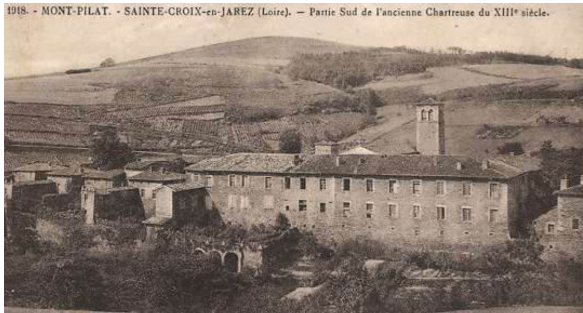
Enduit visible en élévation Sud de la Chartreuse
