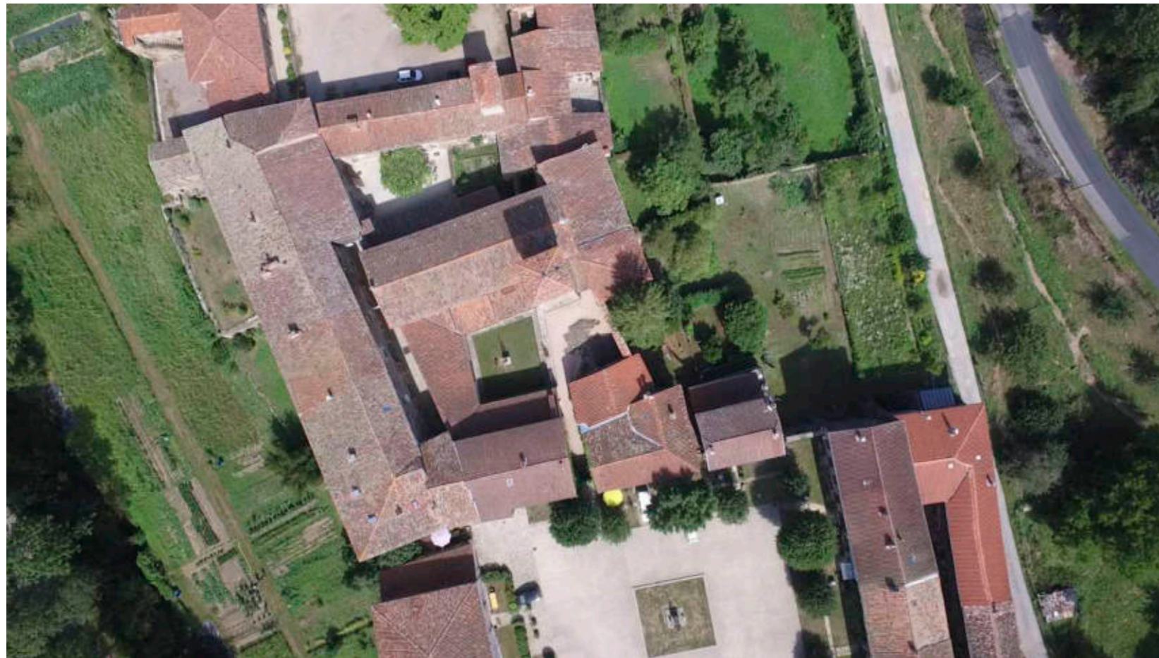
Vue aérienne des couvertures de la Chartreuse, noyau cenobitique, et partie Ouest de la Cour des Frères.
