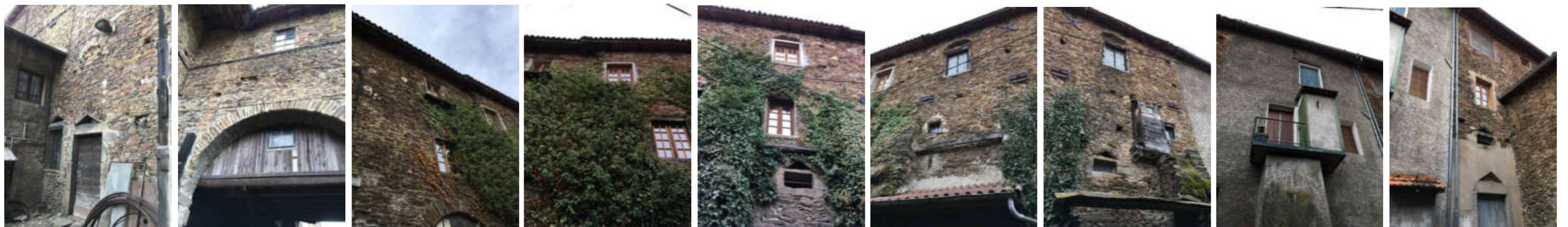
Etat actuel - Photographies Croisée d'Archi Paroi Est Paroi Sud
