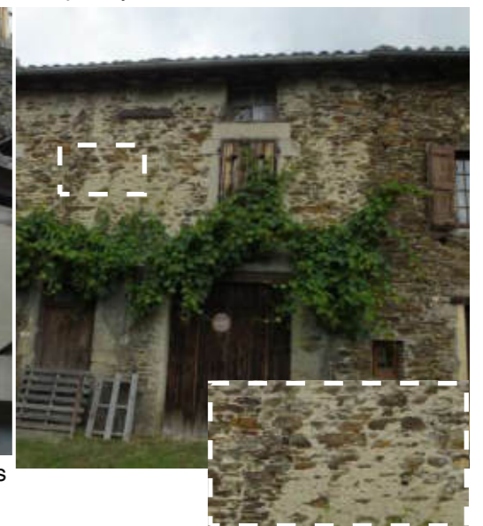
Traces d'enduit chaux ancien
