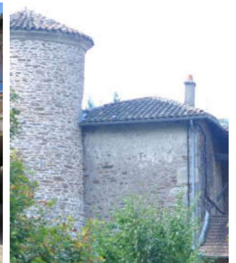
Traces d'enduit chaux ancien
