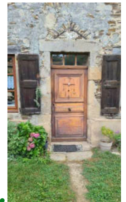
Porte sur Cour des Frères, front Sud, à côté de la mairie
