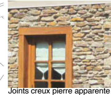
Enduit chaux à pierres vues moderne
