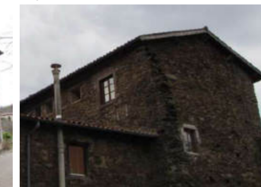
Angle élévation Nord sur impasse du pressoir
