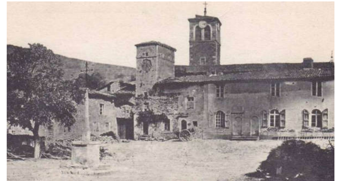
Enduit ancien visible en élévation Ouest sur la cour des Pères (aile Ouest du noyau cénobitique)
