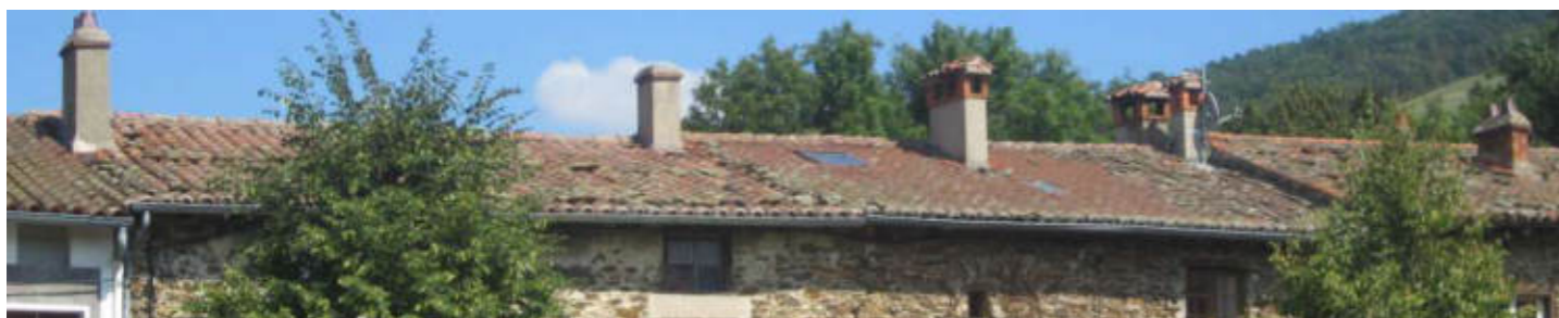
Toitures élévation front Nord de la Cour des obédiences et leur souches de cheminées
