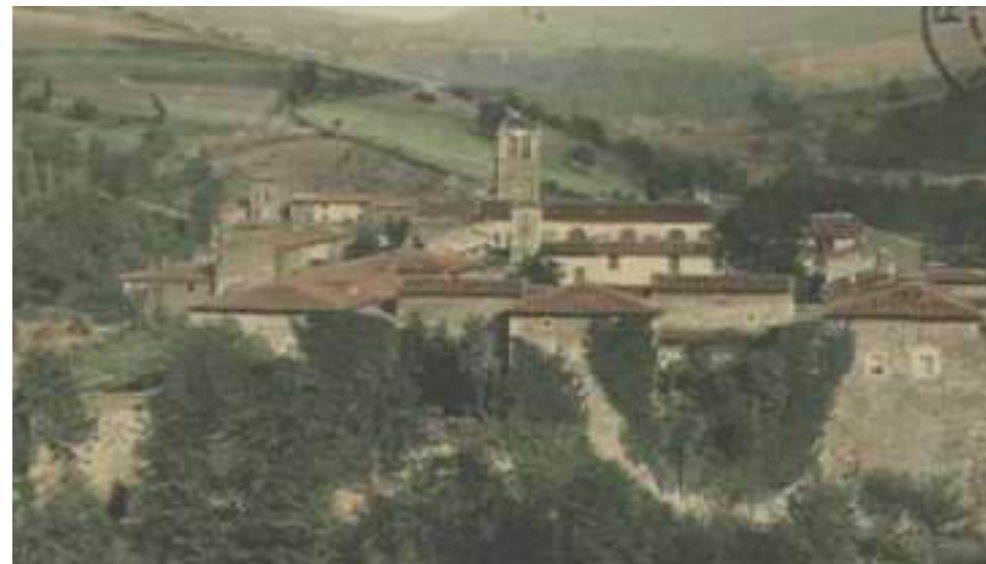
Enduit visible en élévation Ouest de l'église Sainte-Croix II
