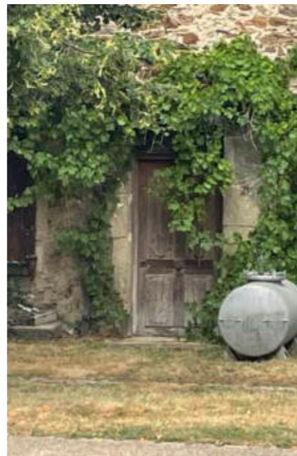
Porte ancienne à deux panneaux => imposte vitrée de faible peut visible (végétation) => si division suivant partition des panneaux de porte => ok On note la présence d'une traverse formant larmier pouvant être prise pour modèle.
