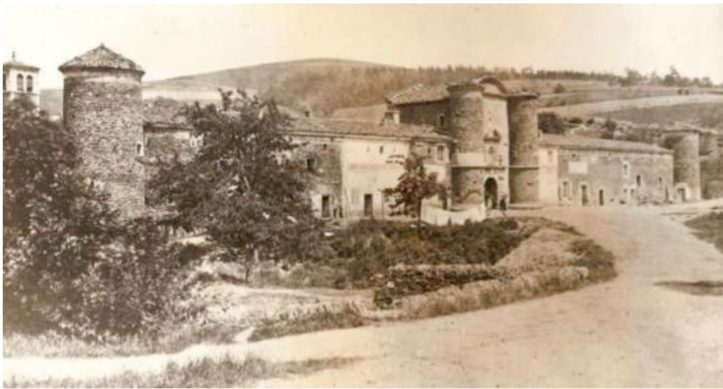
Campagne de travaux -> enduit des élévations fin XIXème s.
