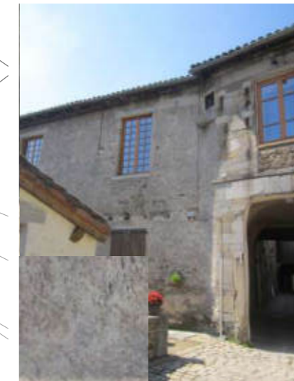
Enduit chaux, et bâtardés chaux/ciment
