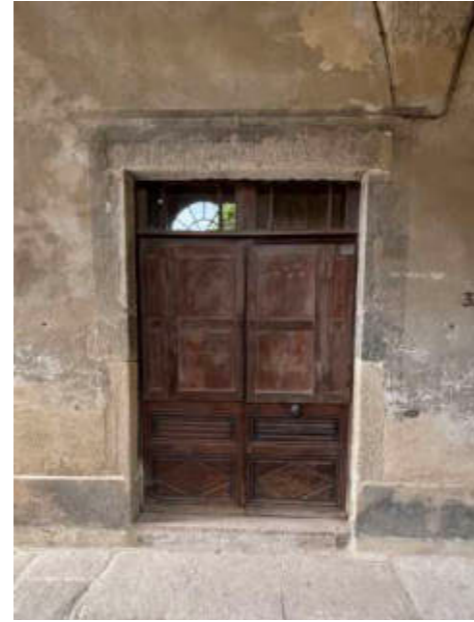
Porte à linteau droit, porte à volet tierçés extérieurs : la partition de l'imposte ne correspond pas aux orientations, mais peut convenir dans ce cas particulier, du fait de la partition du volet extérieur faisant partie de la menuiserie de porte.
