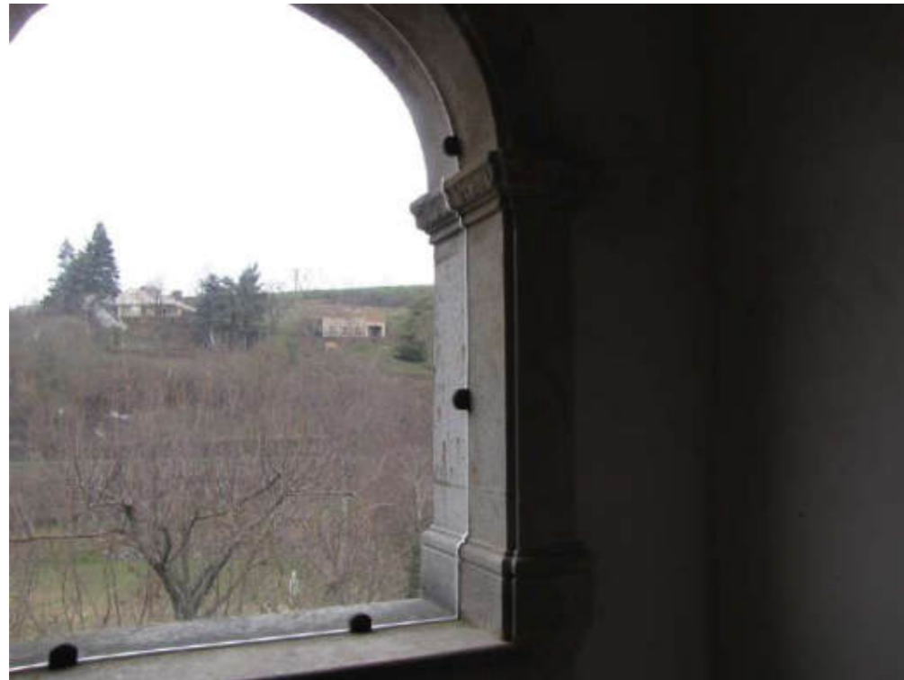
Ouverture en extrémité Ouest de la galerie Nord-Ouest vers cellule du Parc) de la Cour des Pères
