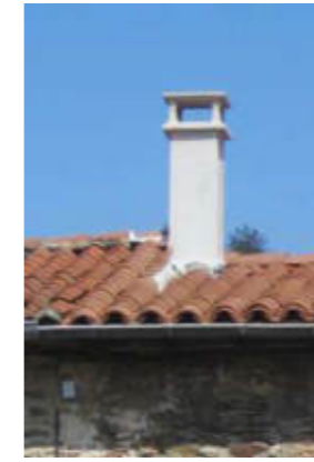
Souche moderne enduite (avec baguettes d'angle PVC) de section carrée et à chapeau en dalle ciment plate
