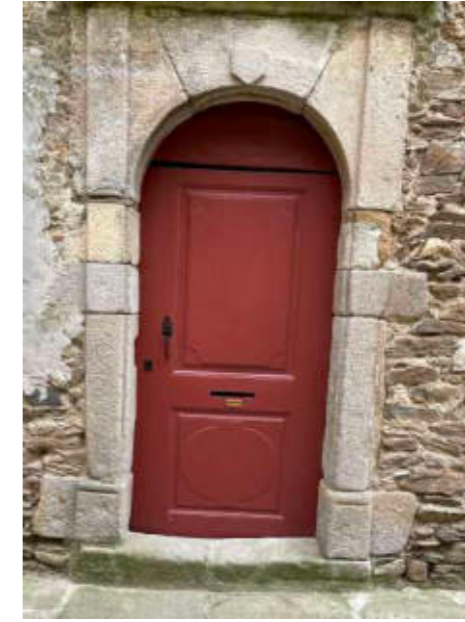
Porte ancienne, menuiserie composite (? , en partie possiblement XVIIè s.) loquet ancien.
