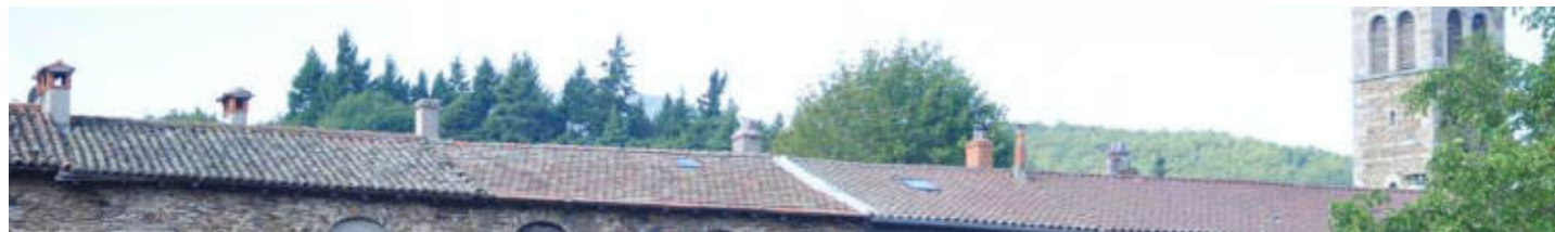
Toitures élévation Nord de la Chartreuse et leur souches de cheminées
