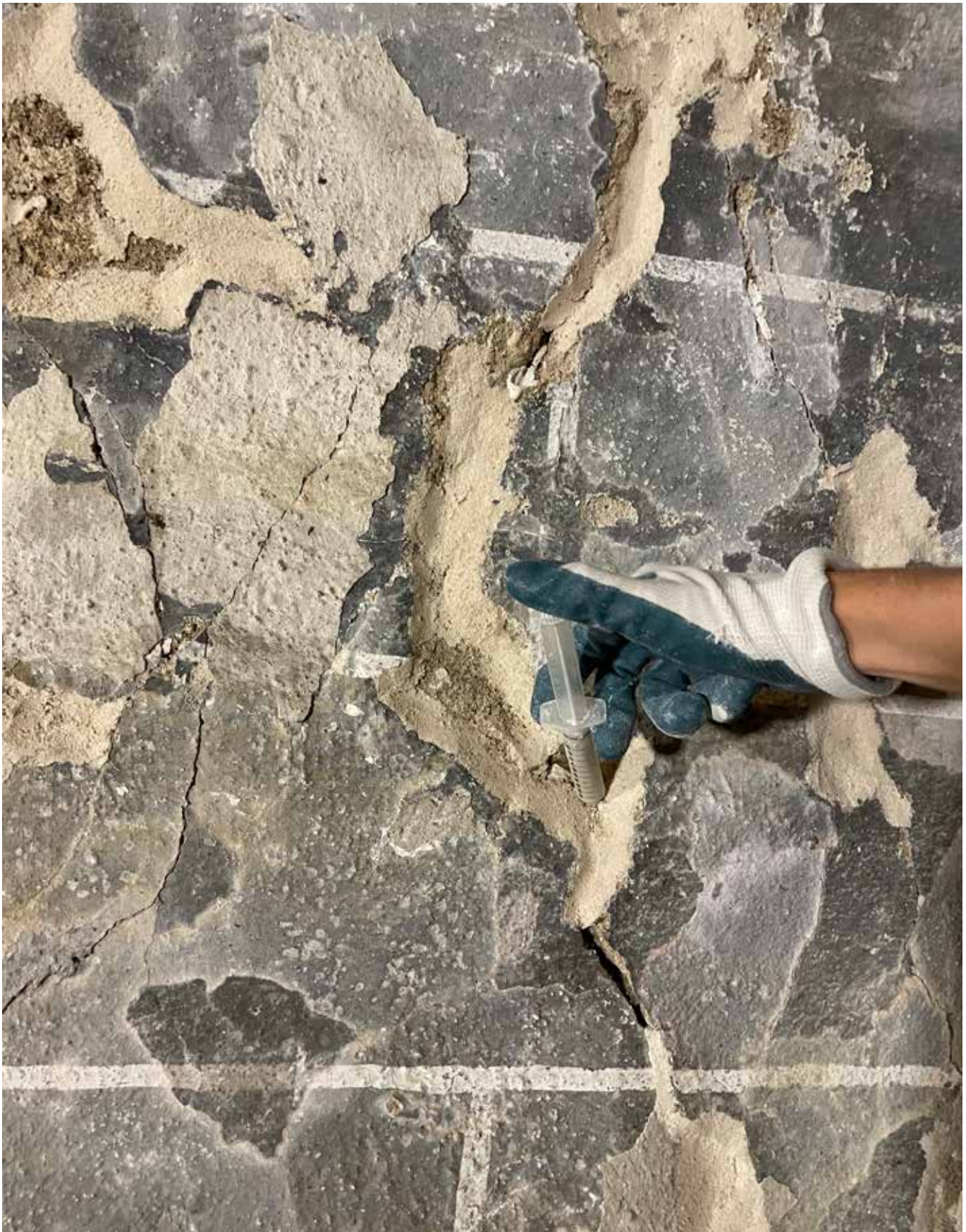
Paroi nord, après réalisation de la consolidation.
