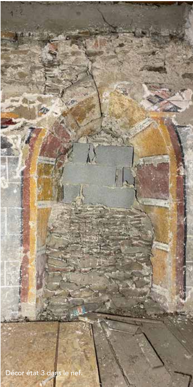
Décor état 3 dans l'ancienne nef.
