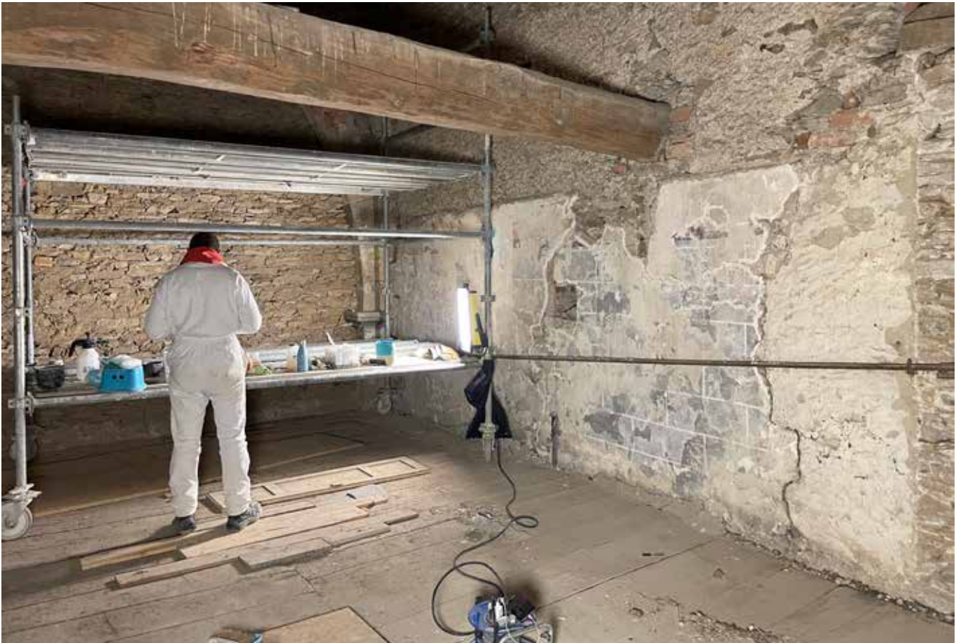
Paroi sud-ouest, après réalisation de la consolidation.
