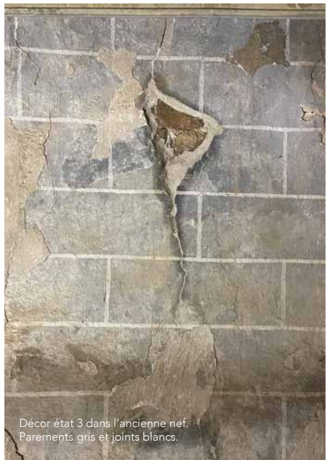
Décor état 3 dans l'ancienne nef.
