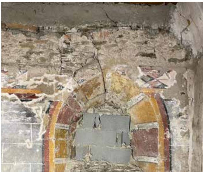
Documentation des enduits peints fragmentaires, fissurés et déplaqués. Photographies en septembre 2023 en cours de consolidation.
